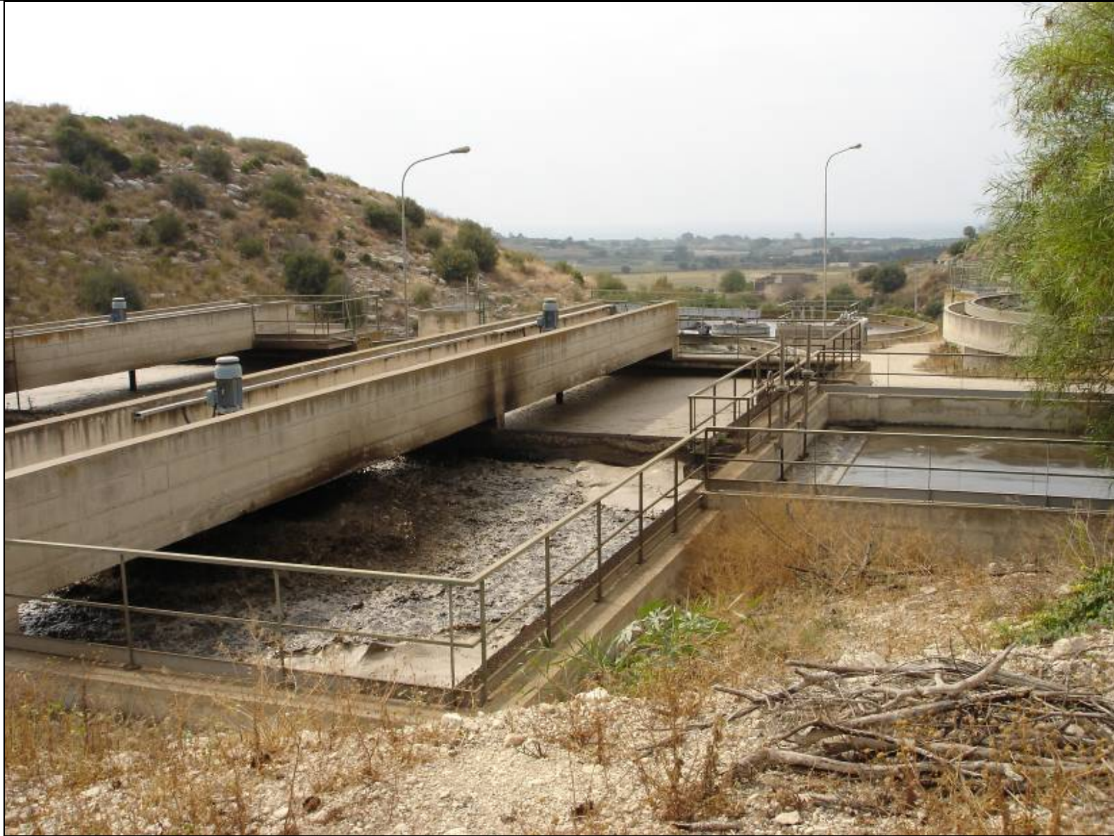
Vista dell'impianto di depurazione di Marina di Ragusa (contrada Palazzo)
