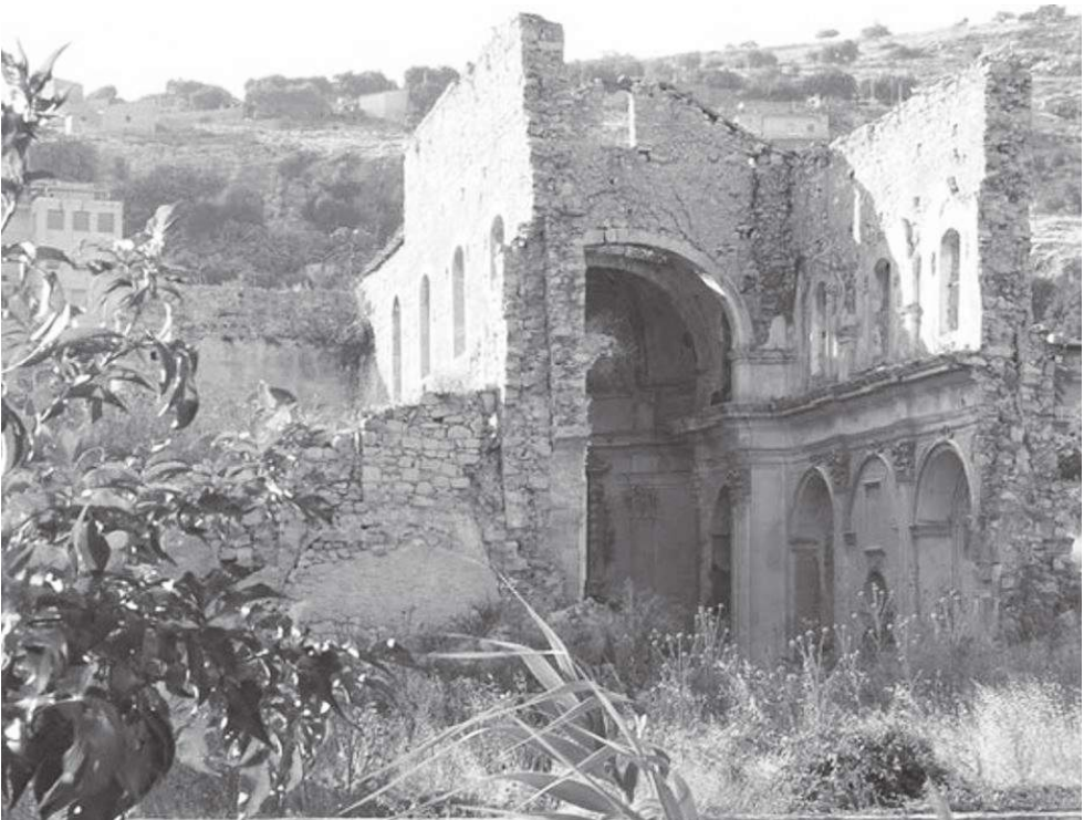
Rudere del Convento di S. Antonino lungo la Fiumara
