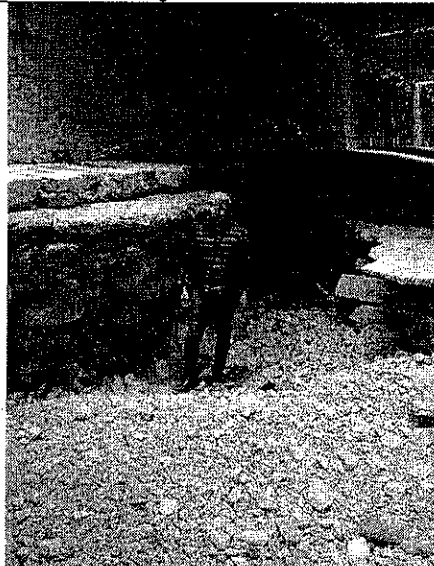
Foto della fondazione danneggiata delle spalle del canale sotto Via Dolomiti, tra innesto Santa Maria La Nova e San Guglielmo, per circa 40 ml
